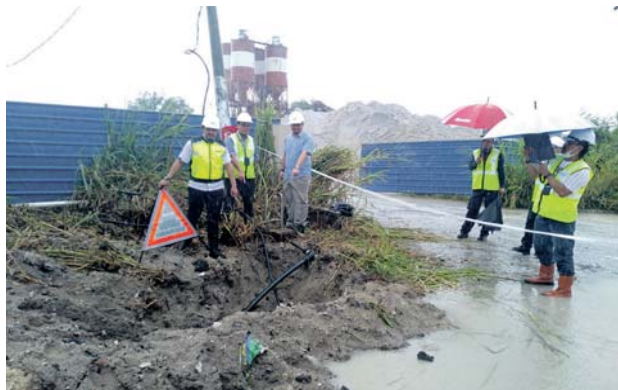
Mohd Fazil (kiri) dan Pengerusi Jawatankuasa Pendidikan dan Perlindungan Pengguna SPAN, Shahr Adnan (dua dari kiri) meninjau keadaan sambungan paip air di sebuah kilang di Kampung Perigi Nenas, Klang semalam.
