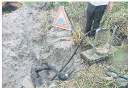
■工厂使用“管”从地下大水管钻洞，非法接驳生水管至工厂利用25厘米和32厘米直径的小水管。
